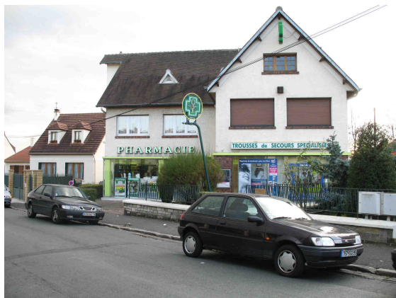
Place Léopold Hirsch – Pharmacie en rez-de-chaussée de pavillon
