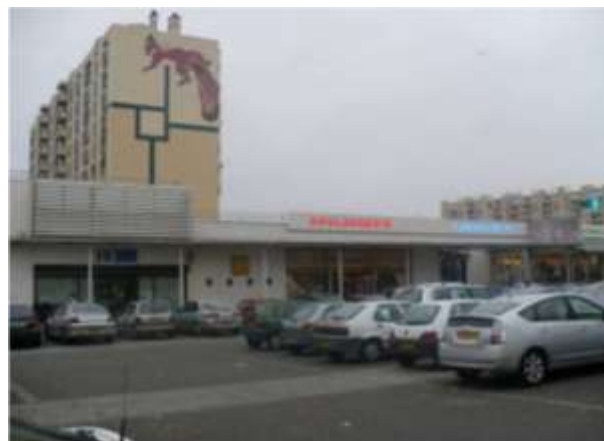
Vue du linéaire commercial du parking Place des Sablons
