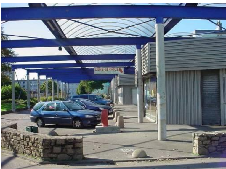
Vue du parking situé à l'arrière du centre commercial
