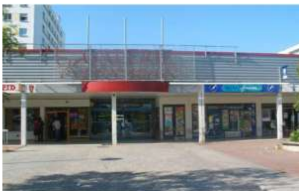
Vue de face de la Galerie Kervénanec
