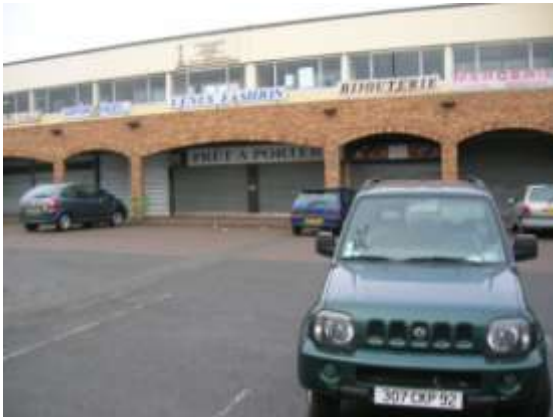
Barrette commerciale donnant sur le parking
